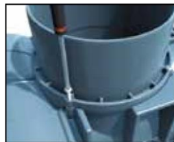
Kanālu novieto paredzētajā vietā, veic sānu piebetonēšanu un ceļa seguma izveidi
