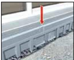
Veic sānu piebetonēšanu un virsmas seguma izveidi
