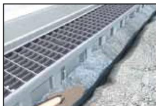
Veic sānu piebetonēšanu un virsmas seguma izveidi
