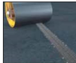
Kanālu novieto paredzētajā vietā, veic sānu piebetonēšanu un ceļa seguma izveidi
