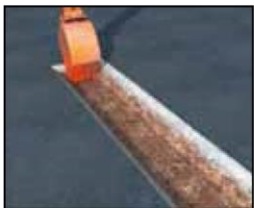
Kanālu novieto paredzētajā vietā, veic sānu piebetonēšanu un ceļa seguma izveidi
